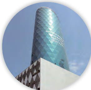
Бізнес-центр Millenium Tower, Манама, Бахрейн
